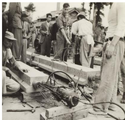
写真-1.2 緊張状況
