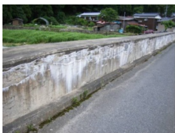
写真 2.3.1 L 側桁部内側の状況
