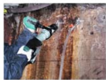
ハンマードリルによる注入孔穿孔
