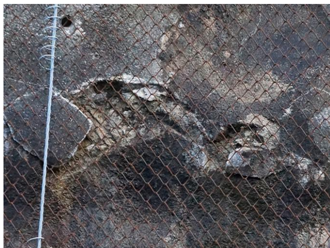
写真 - 18 コンクリート表面の観察
