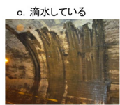
※覆工背面の土砂流出→空洞の原因となる
