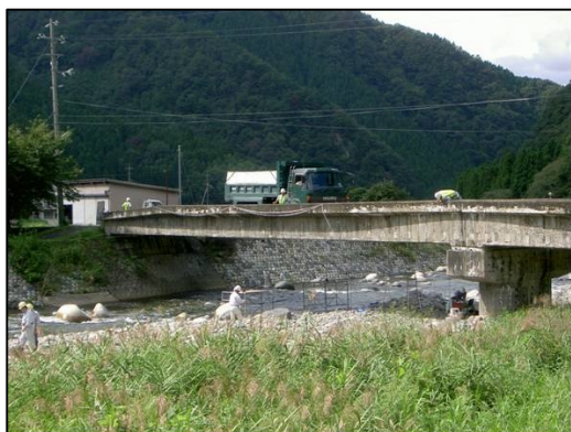
写真 2.3.7 一台載荷試験状況
