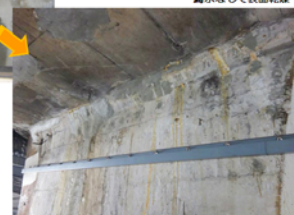
施工後 漏水なしで表面乾燥
