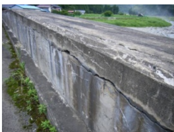
写真 2.3.3 R 側桁部内側の状況
