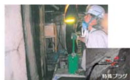
ケミカルポンプによる注入と特殊プラグ
