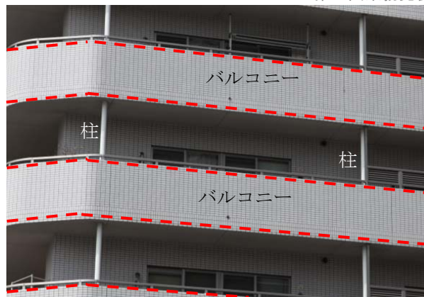
写真 4-1 東面 可視画像 (柱とバルコニーが独立している)
