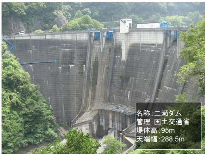
写真-5 ダムの点検事例
