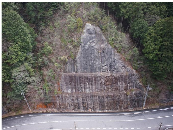
写真 - 15 吹付け法面の点検事例
