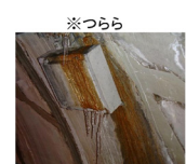
※覆工背面の土砂流出→空洞の原因となる
