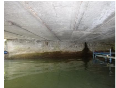
写真-4.1 桁下状況
