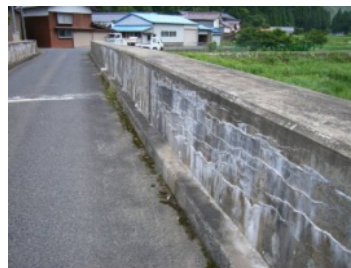
写真 2.3.2 R 側桁部内側の状況
