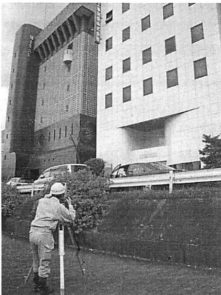
写真2 外部からの調査の様子
