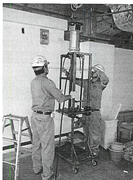
写真1 コンクリート内部の欠陥や配筋状況に関する X 線を用いた調査
