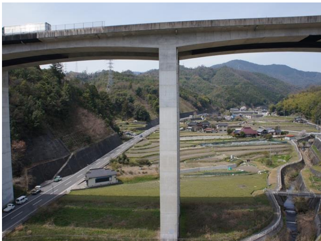
写真 - 9 橋梁下部工の点検事例
