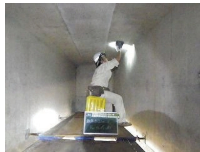
【写真-6 鋼材探査状況】
