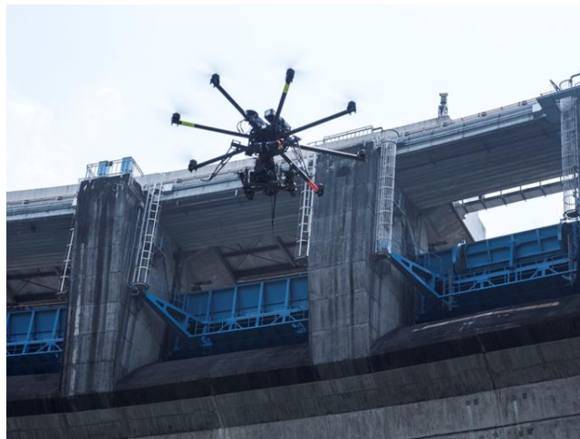
写真 - 8 ダムの点検状況
